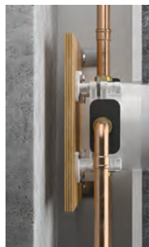
4. Vorwand-Installation auf Trägersystem
