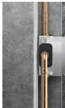
1. Installation in der Wand
