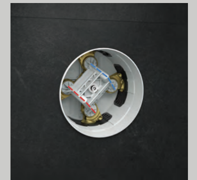
3. Rohrleitungen mittels vormontiertem Spüleinsetz durchspülen.
