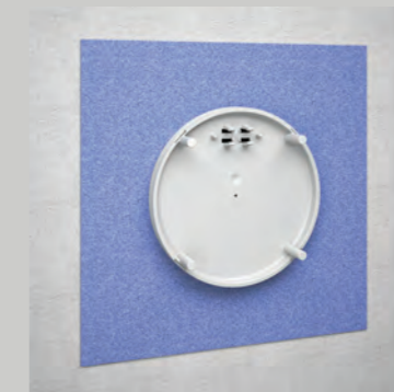
2. Dichtvlies für Bauwerksabdichtung auf fertig verputzte und vorbehandelte Wand kleben.
